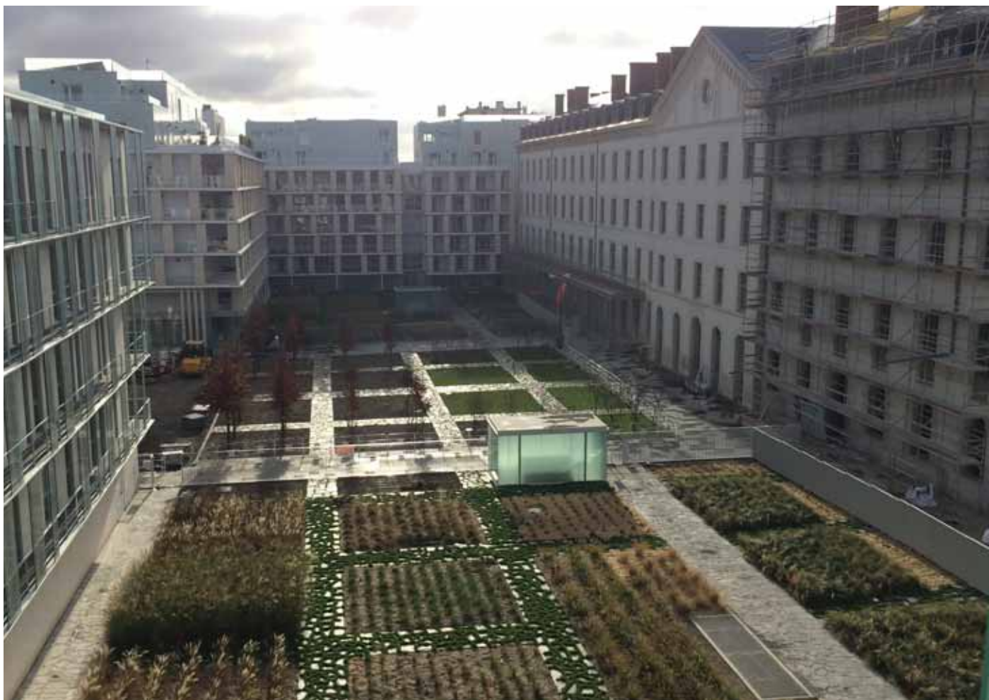
Vue de chantier
