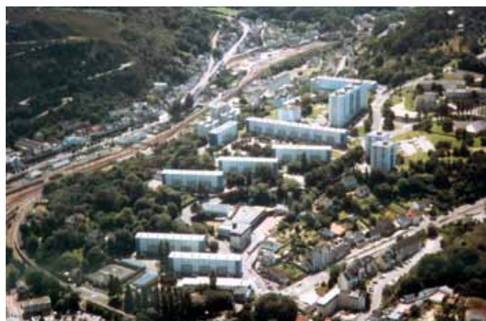
Amont Quentin - Avant démolition
