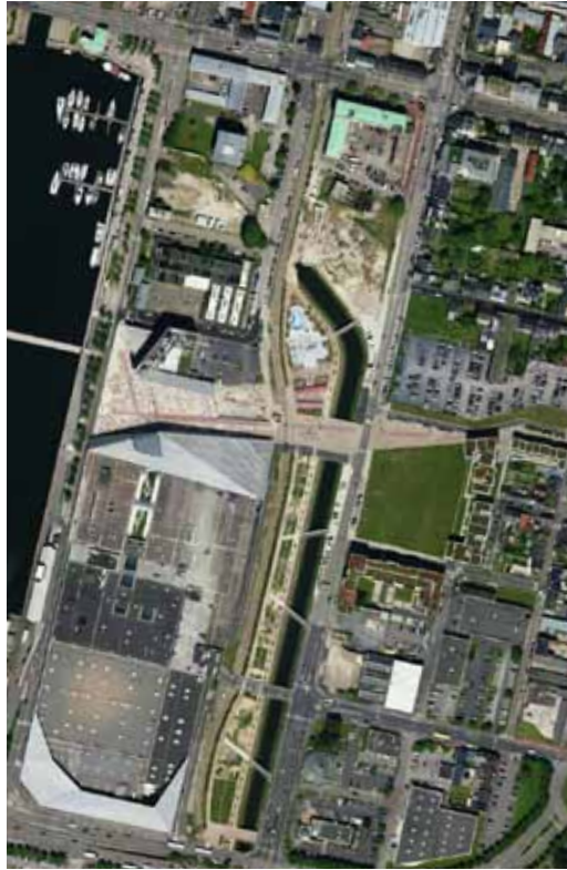
Chantier en cours : 2015]
