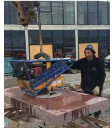
Tous les dallages et pavages ont été posés par l'entreprise Oise-Environnement.
