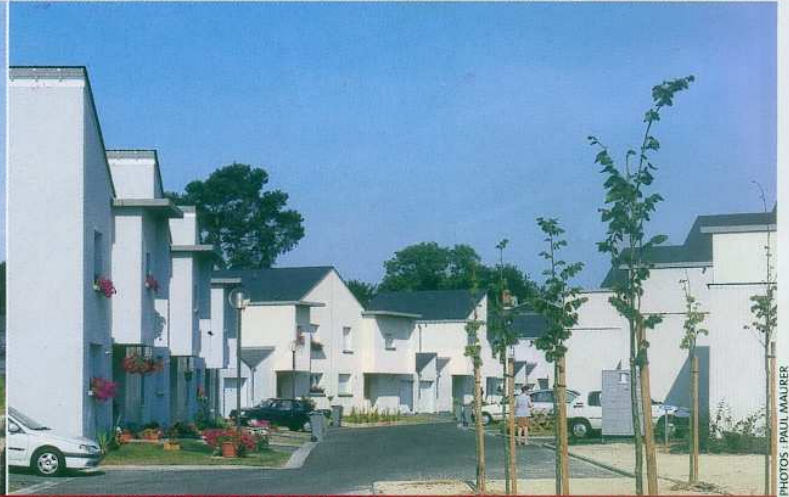
LES MAISONS SONT IMPLANTÉES À FAIBLE DISTANCE LES UNES DES AUTRES.
