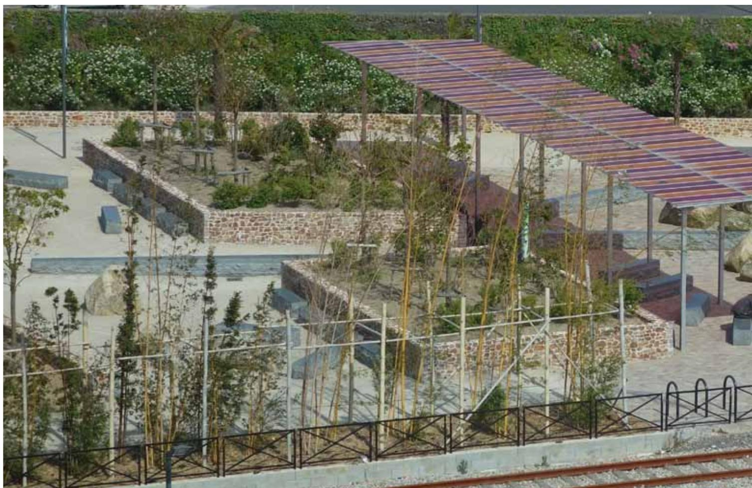
Dans l'alignement de la Place Jacques Hébert, trois auvents abritent du soleil et de la pluie. Ces auvents sont réalisés en ossature aluminium portant une toiture en «altuglass» coloré.
