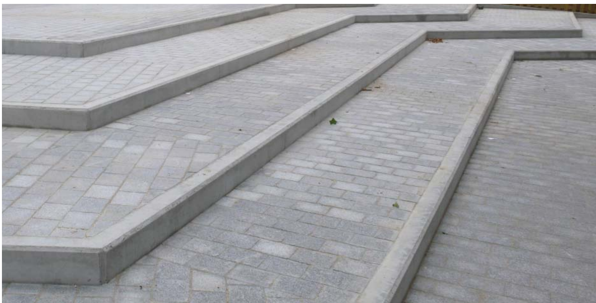
Emmarchement nez de marche en béton remplissage en pavé granit gris clair 20*15 cm, épaisseur 8 cm face vue flammée, chants éclatés
