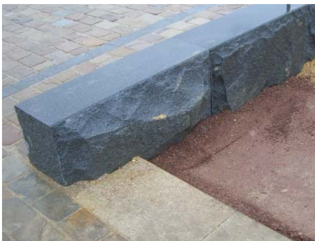
Bancs en granit noir 200*30*43 cm de hauteur vue assise polie et faces éclatées
