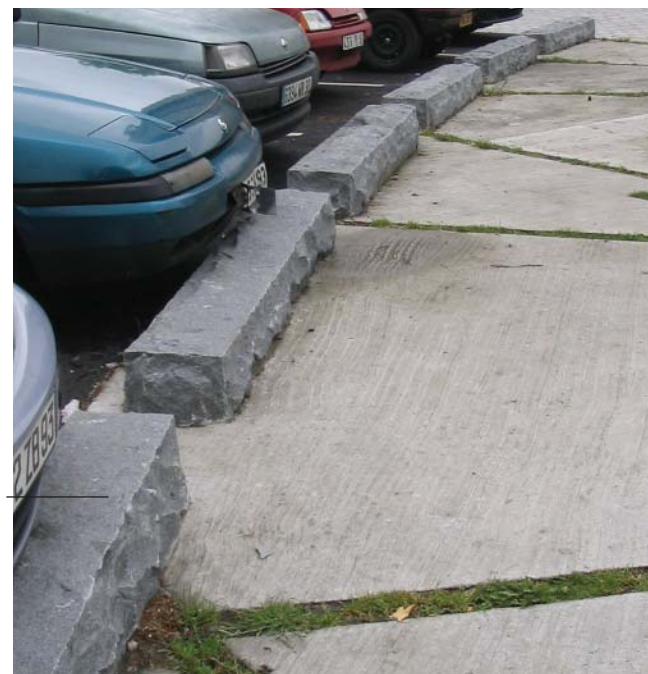
Borne anti-franchissement 30*30*30 cm de hauteur vue toutes faces éclatées
