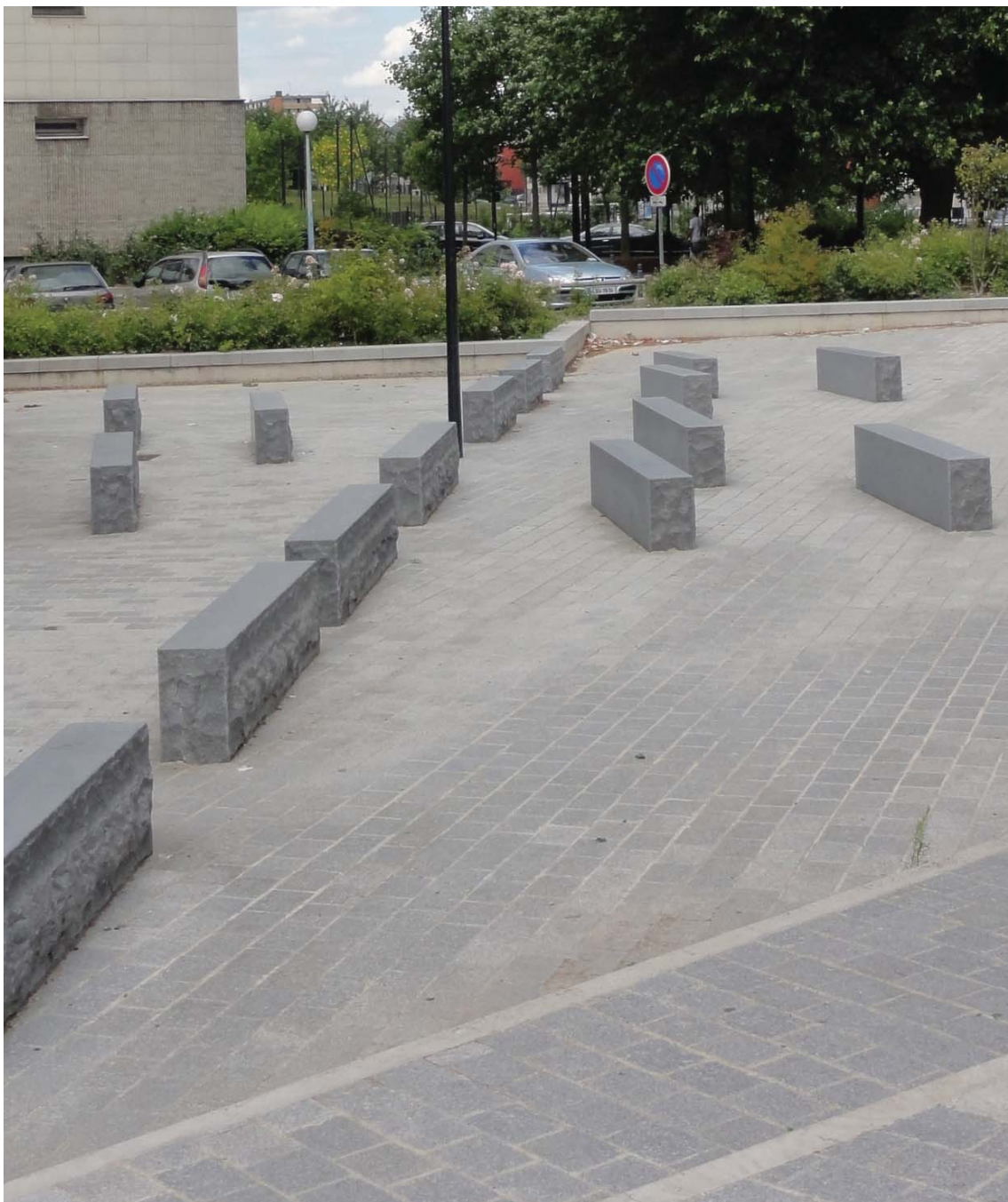
Bancs en granit noir 200*30*43 cm de hauteur vue assise polie et faces éclatées
