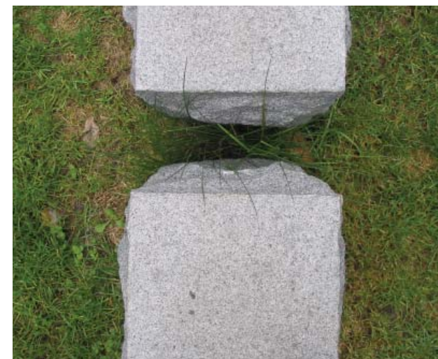
Fondation de passerelle en bois largeur 30cm, longueurs et hauteur vue variables assise flammée et faces éclatées
