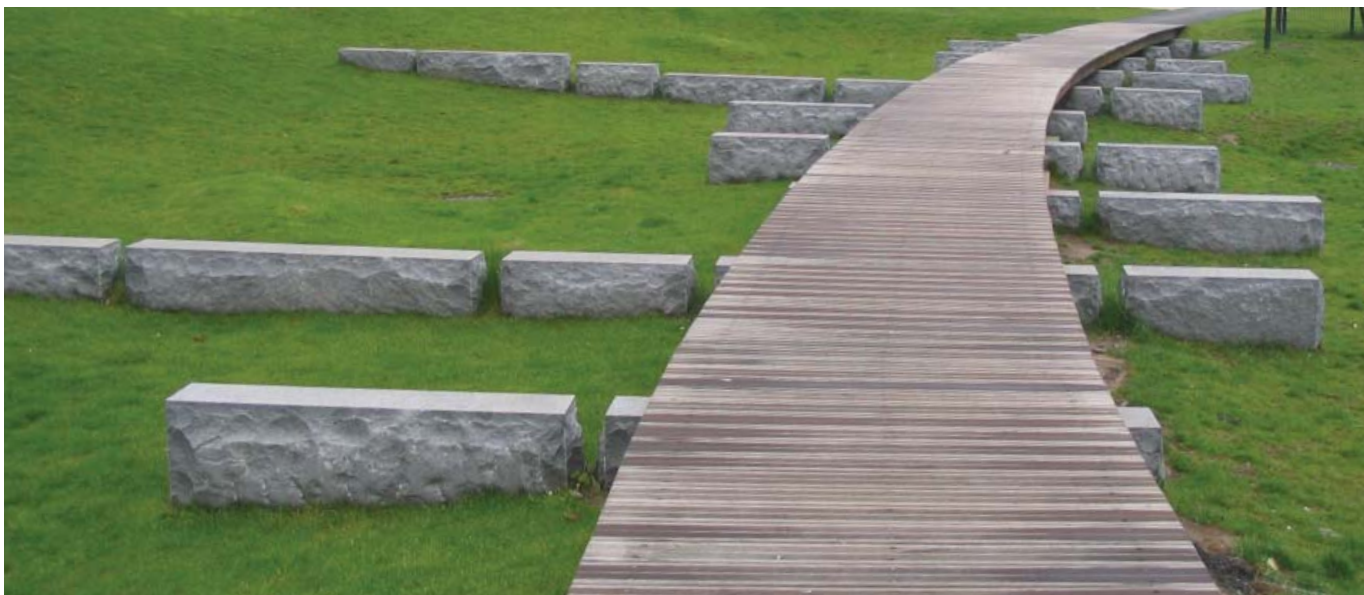
Fondation de passerelle en bois largeur 30cm, longueurs et hauteur vue variables assise flammée et faces éclatées
