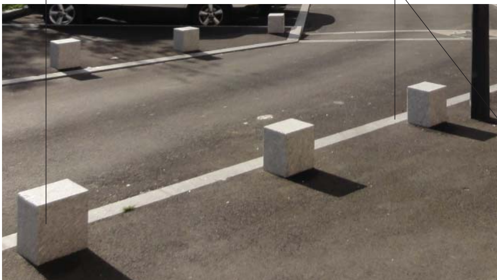
Borne anti-franchissement 30*30*30 cm de hauteur vue toutes faces flammées
