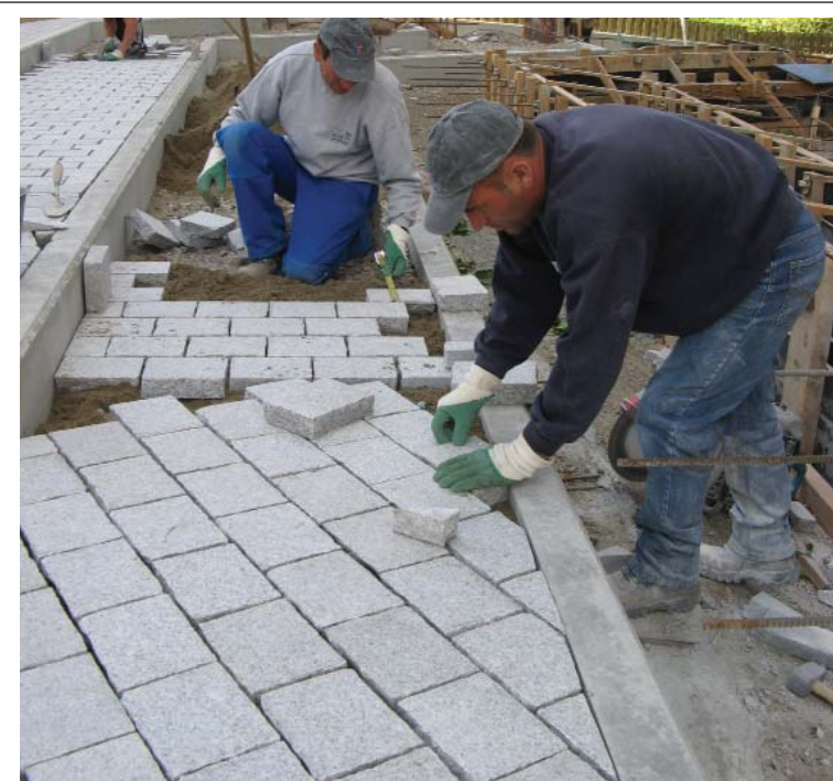
Emmarchement nez de marche en béton remplissage en pavé granit gris clair 20*15 cm, épaisseur 8 cm face vue flammée, chants éclatés
