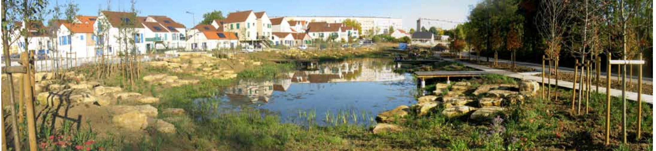
Fin des travaux - 2008
