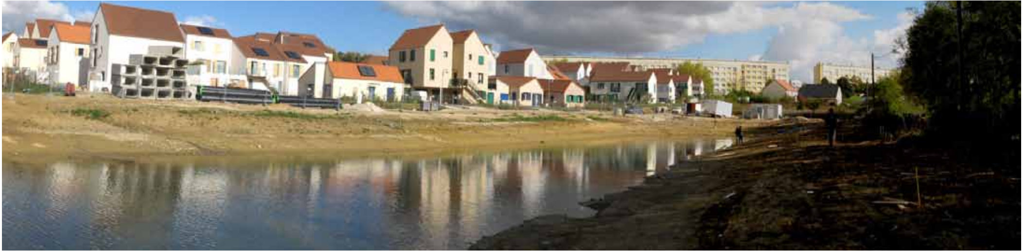
Début des travaux - 2007
